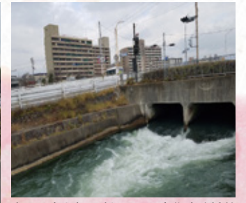
京阪電車上部の暗渠より、七条塩小路橋付近で排出され地上を流れる。
