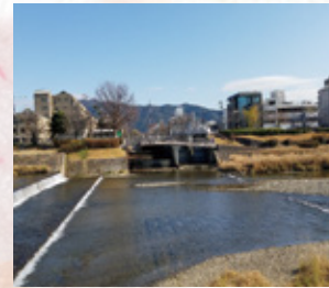
疎水鴨川排水口と鴨川に沿って、地下化された京阪電車上部の暗渠へ流す分流点を鴨川対岸より撮影。
