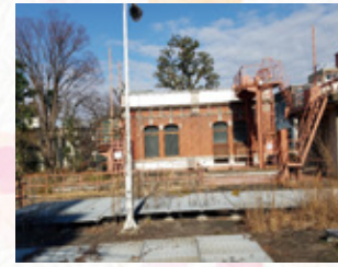
夷川発電所1912年第二琵琶湖完成に伴い、1914年4月より発電、現在280KW常時出力、落差3.4mで発電している。(夷川は夷川通りに由来する)
