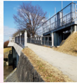
疎水鴨川排水口と鴨川に沿って暗渠で流す分流点。
