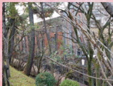
第二期蹴上発電所と第三期発電所の導水管。落差33.5m。
