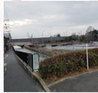
七条塩小路橋より下流を見る。
