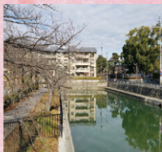
相撲場付近で西に屈折する疎水。
