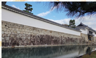
東南隅櫓方面より東大手門・外堀を見る。
